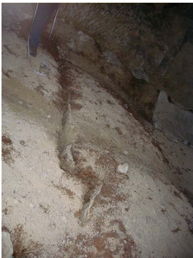
Cava di Pietra da cantoni in Loc. Colma; particolare si notano le ampie e profonde crepacciature verosimilmente indotte dal sisma del 21/2/2001
